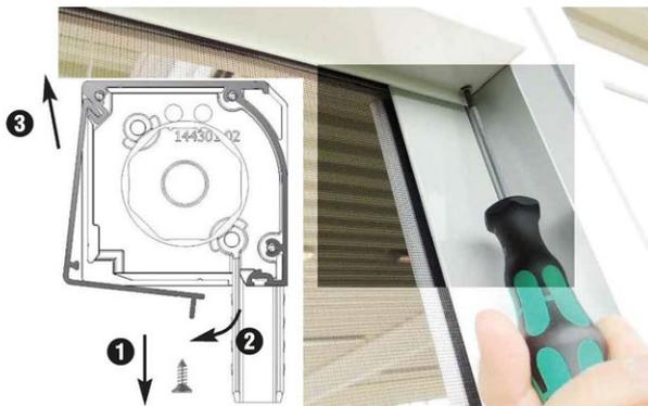
Zum Öffnen der Kastenblende diese rechts und links an der Kastenkappe nach unten ausklipsen **2**. Anschließend nach oben wegschieben **3**.
